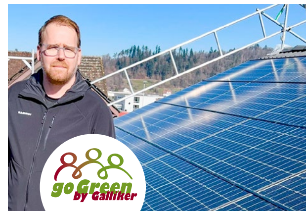
Fabian mit seiner nagelneuen Photovoltaik-Anlage
